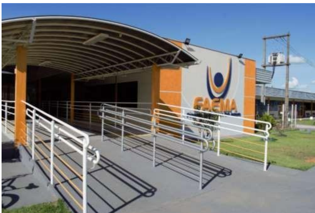
Figura 5 - Entrada para as instalações do Centro Universitário FAEMA – UNIFAEMA
